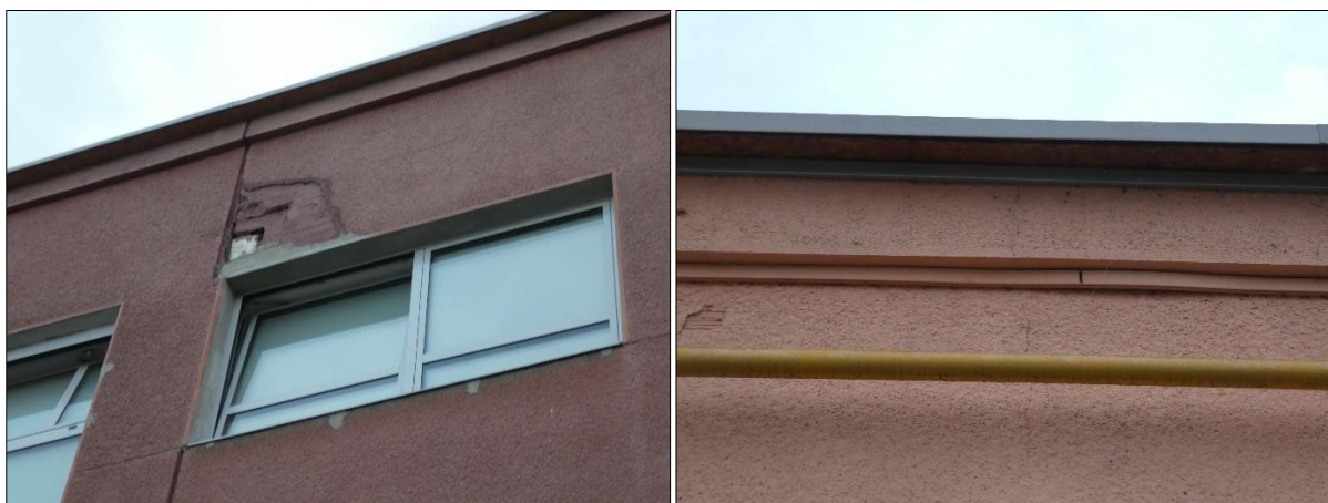
Obr. 5: Vertikální spáry (vlevo), podstřeší kryté lištami (vpravo)
